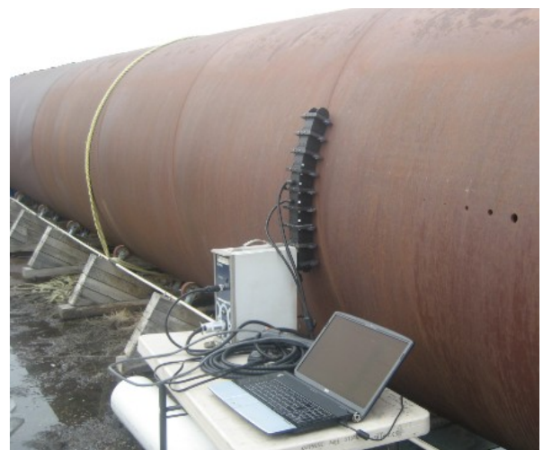
Рис. 1 д): Датчик ТТ на трубе диаметром 2 м.
